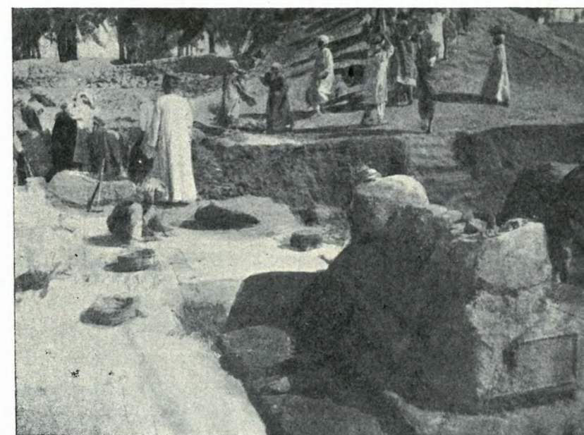
Fig. 17. — MUR COPTO-BYZANTIN BOUCHANT LA PORTE SUD DU MUR-PYLÔNE, VU DU SUD-OUEST.
